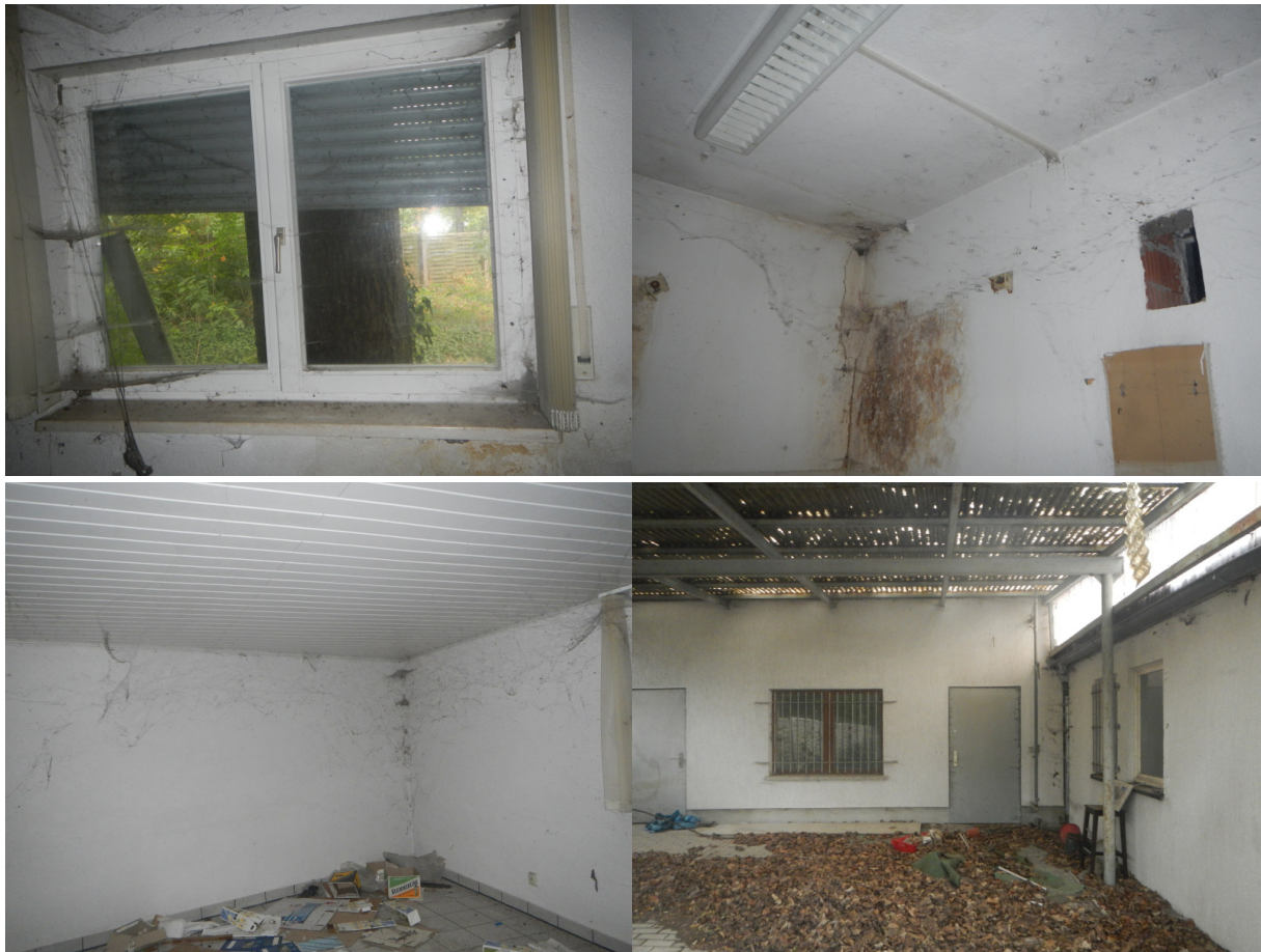
Abb. 2: Fotodokumentation zum Gebäudealtbestand
