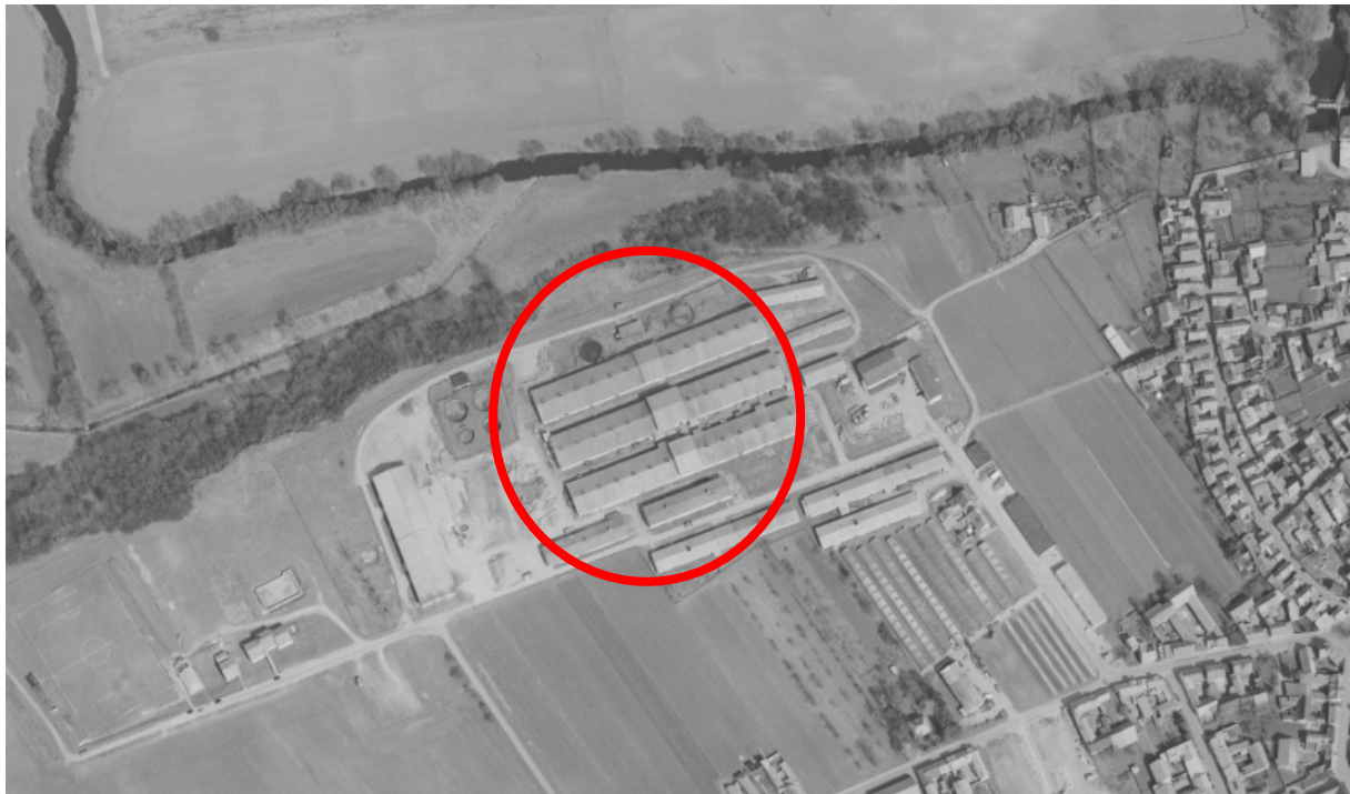
Abb. 2: Luftbildaufnahme des Plangebietes mit Rindermastanlage 1996
